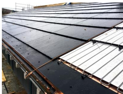
Endmontage der PVT-Module, Ergänzungsplatten und des Zubehörs. Einfacher Ersatz der PV-Module jederzeit möglich.
