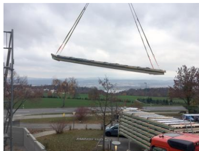
Montage der Elemente. Schon nach 1 Tag war das Dach dicht.
