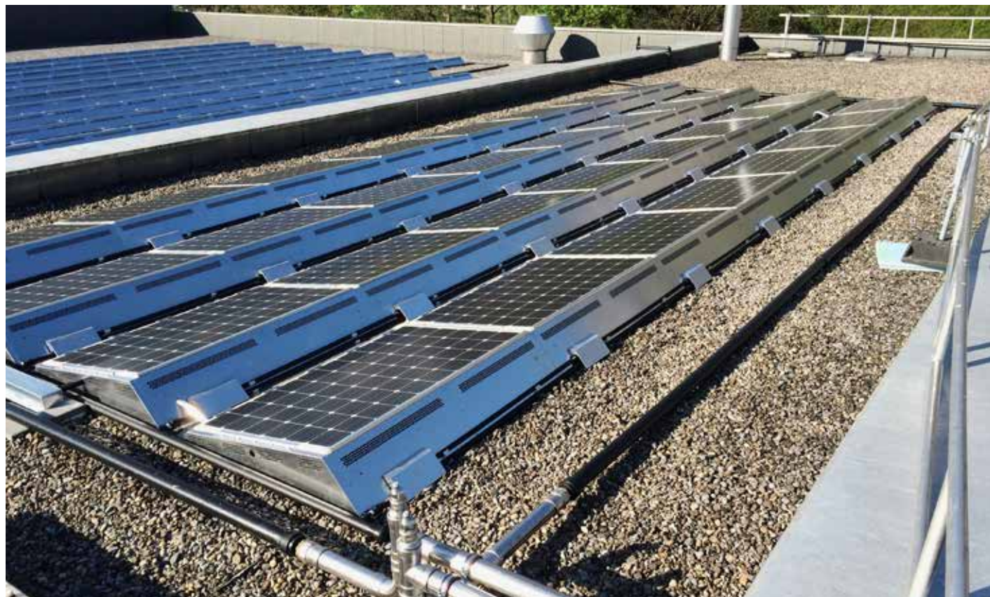
Solar-Hybridanlage, die zugleich Strom und warmes Wasser produziert: Die von Hansjürg Leibundgut prophezeite Entwicklung ist heute Tatsache.
