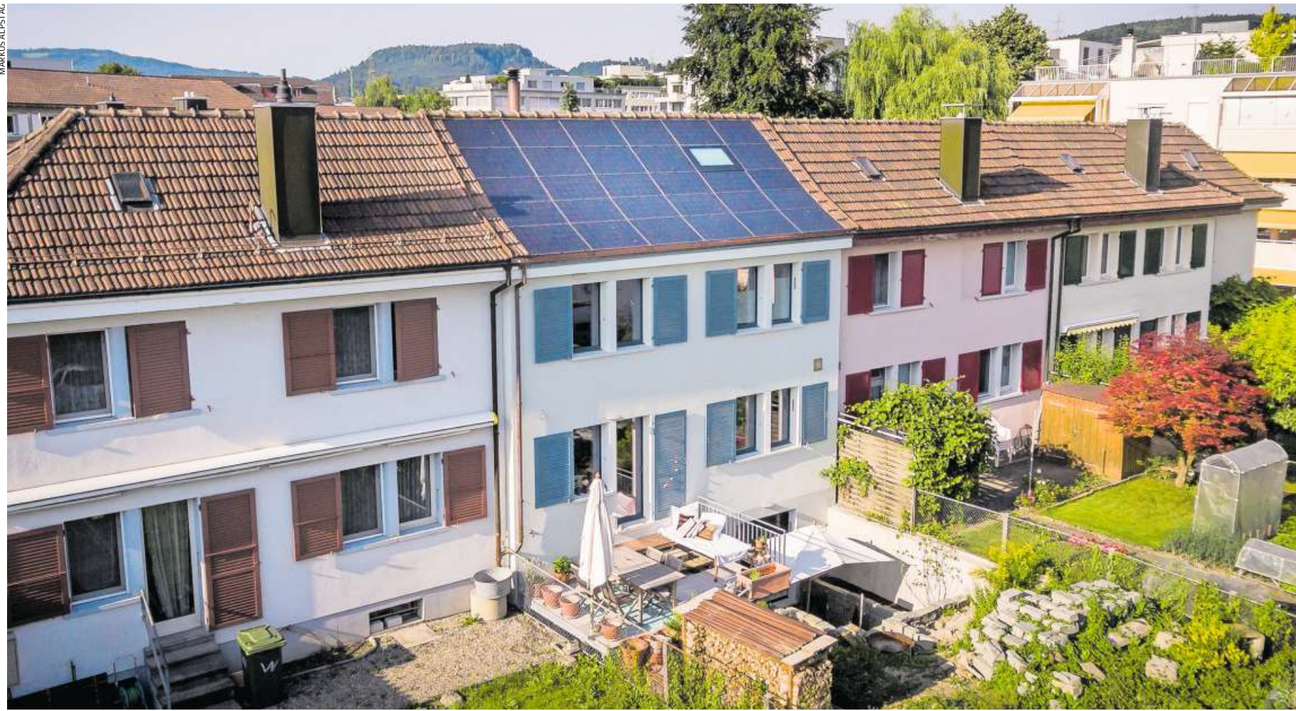
Reiheneinfamilienhaus in Zug: Dank besserer Dämmung braucht das Haus noch halb so viel Energie, und dank der Solaranlage wird viel davon umweltgerecht produziert.
