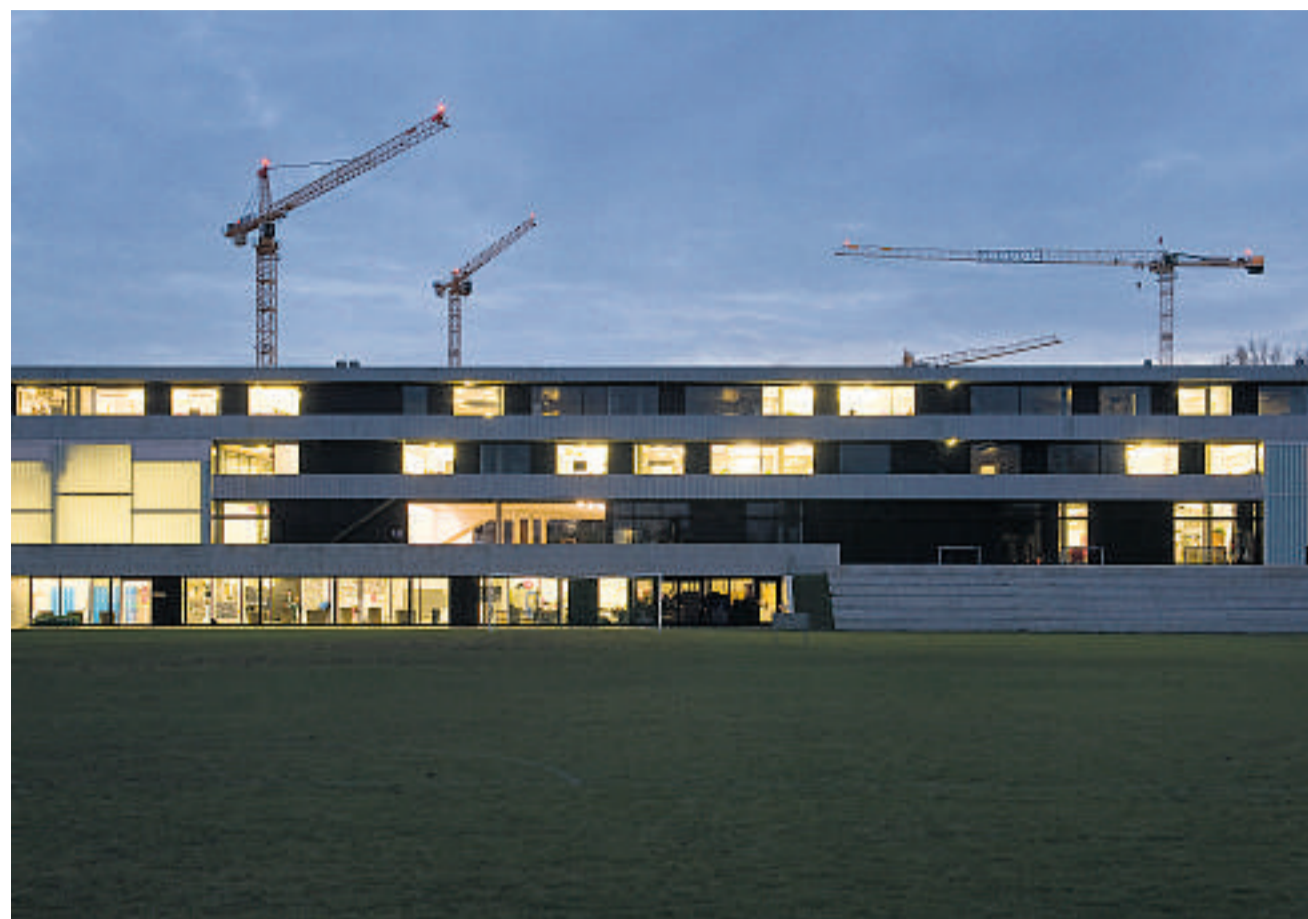
Ein Beispiel für nachhaltiges und günstiges Bauen: die Zurich International School in Adliswil.
